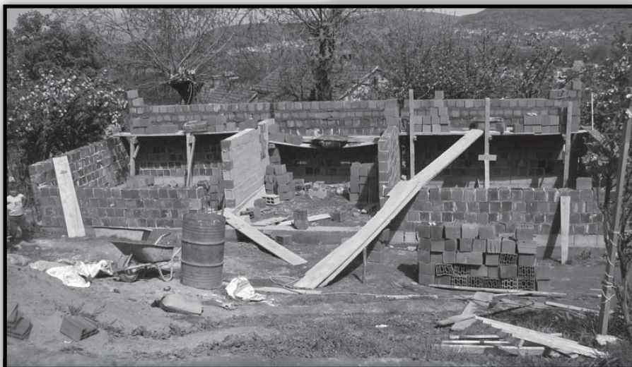
Fillimi i ndërtimit të njëres prej këtyre shtëpive
