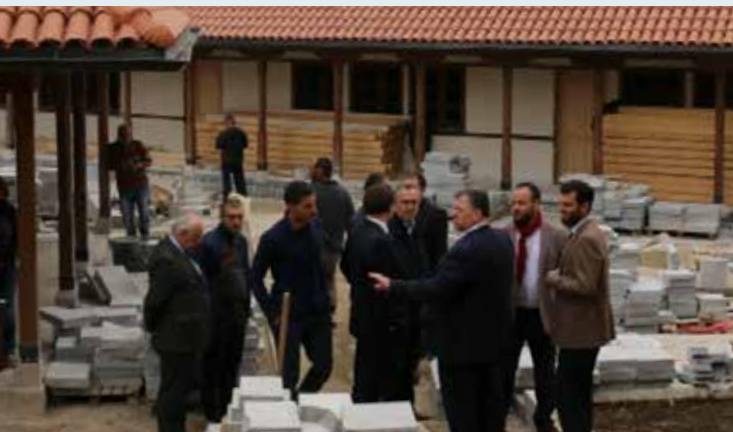
Myftiu Tërnavë gjatë inspektimit të punimeve
